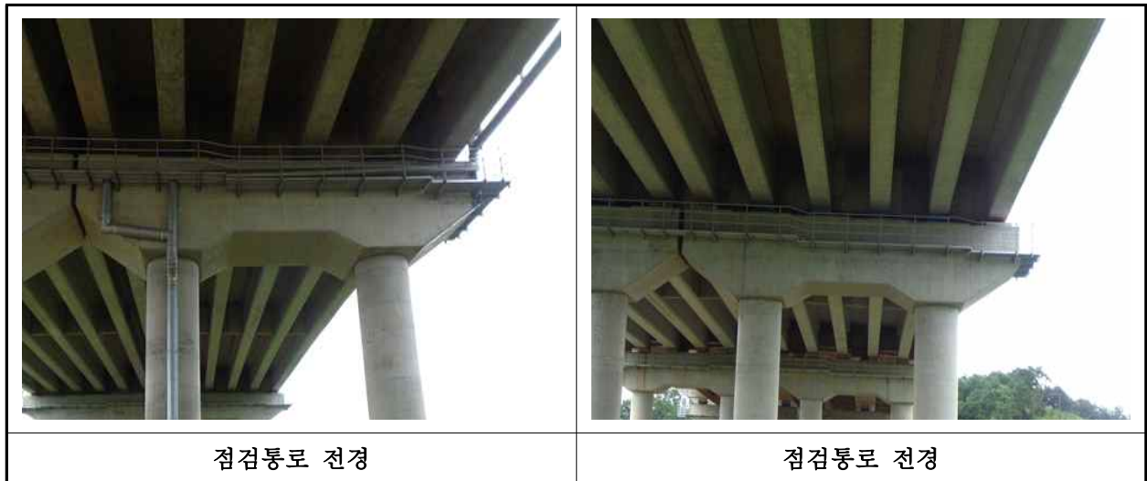
【사진 9.3.25】 교량 점검시설 전경
