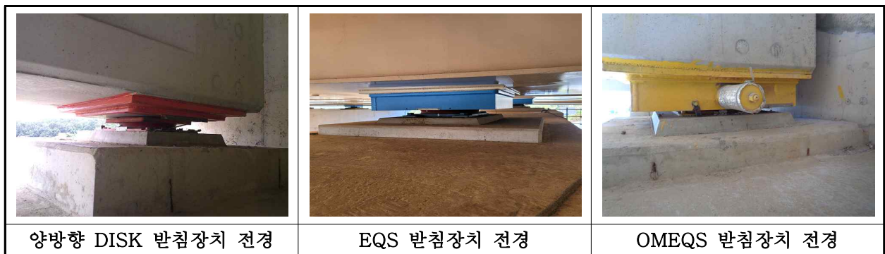
【사진 9.3.12】 교량받침 전경
