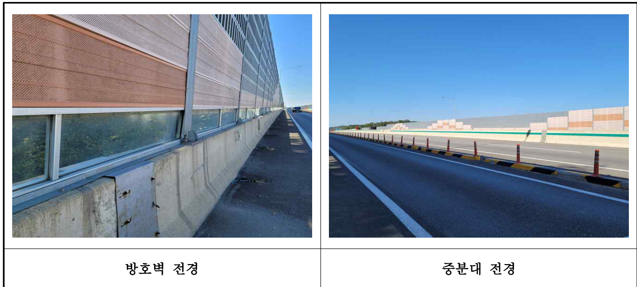
【사진 9.3.23】 방호벽 및 중앙분리대 전경
