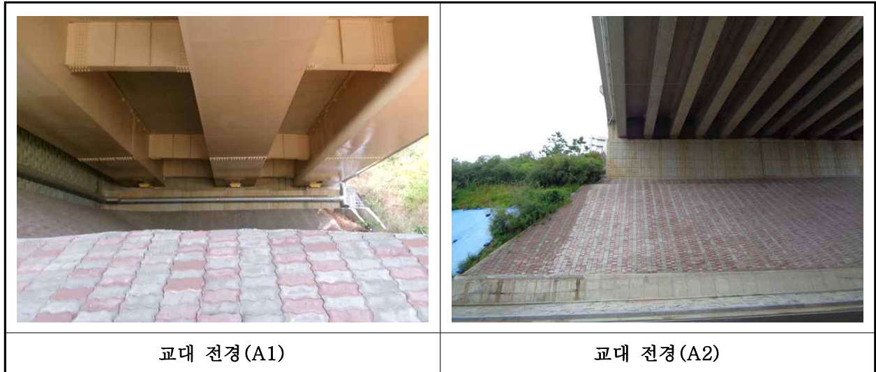
【사진 9.3.8】 교대 전경
