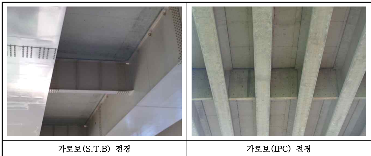
【사진 9.3.6】 가로보 전경
