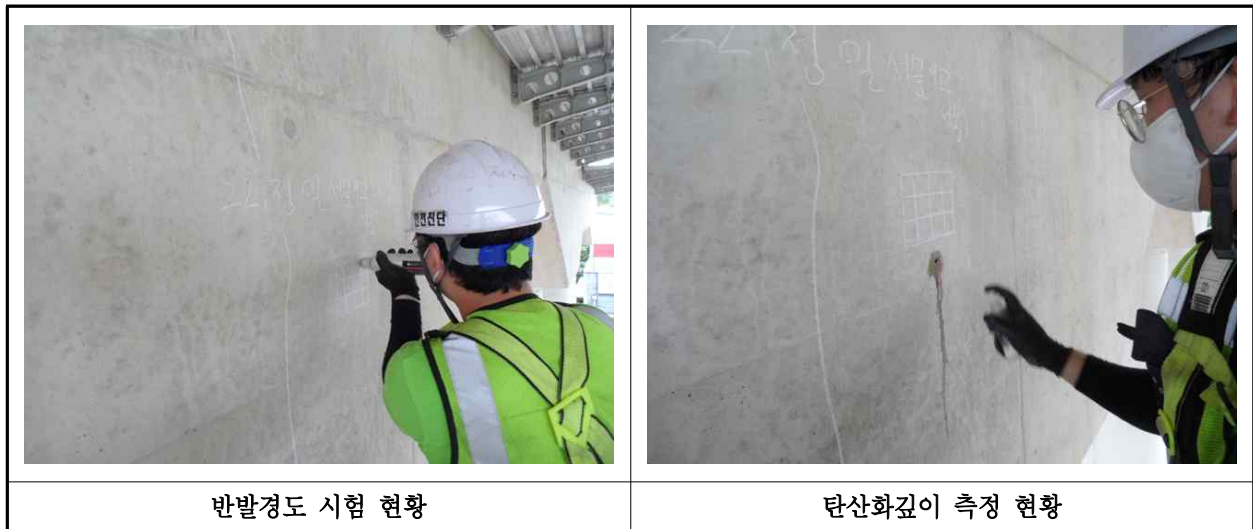
【사진 9.4.1】 콘크리트 내구성조사 현황
