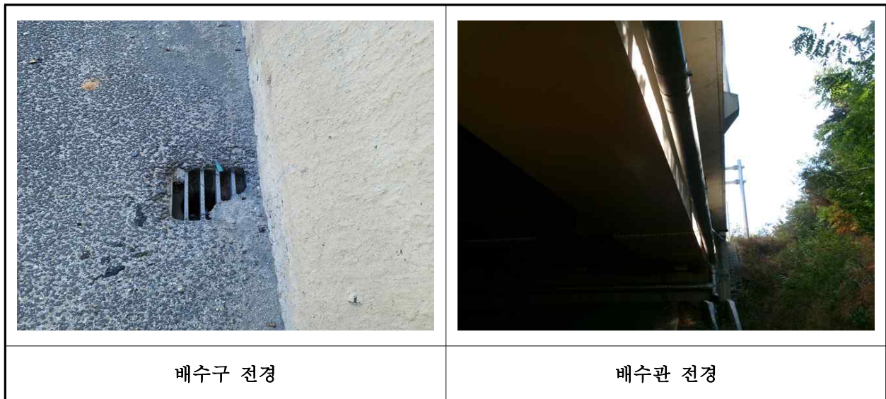
【사진 9.3.21】 배수시설 전경
