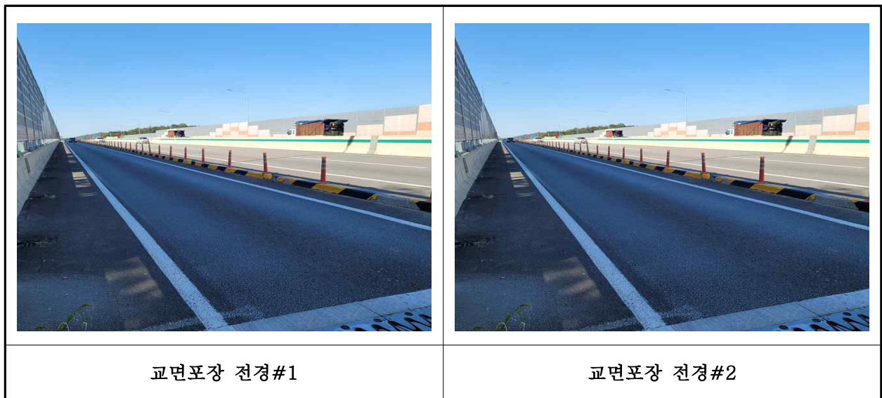
【사진 9.3.19】 교면포장 전경
