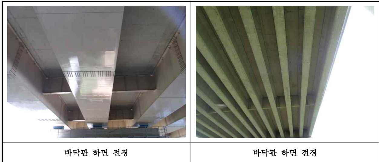
【사진 9.3.2】 바닥판하면 전경
